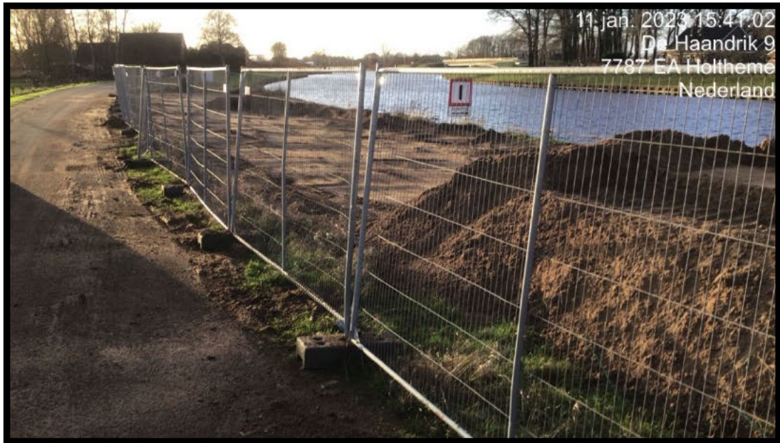
Foto 2: Depot 1 (zand zijkanten) bij elkaar geschraapt en rechtsvoor nog aanwezig.
