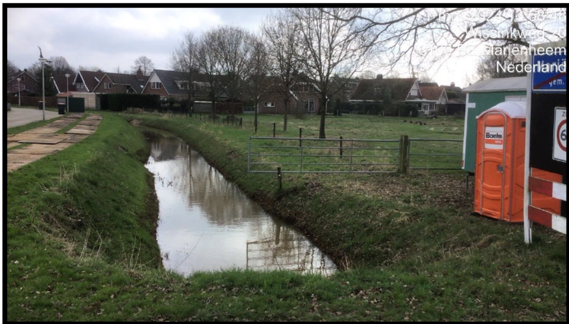
Foto 6: Nog niet gebaggerde waterloop stroomopwaarts van Wissinkweg. Betreft het gemelde tracé.
