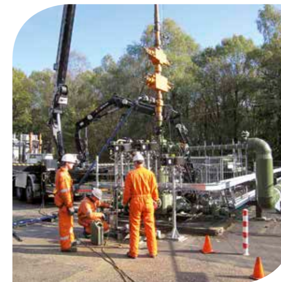
Een voorbeeld van een omgebouwde gaswinlocatie tot waterinjectielocatie.
