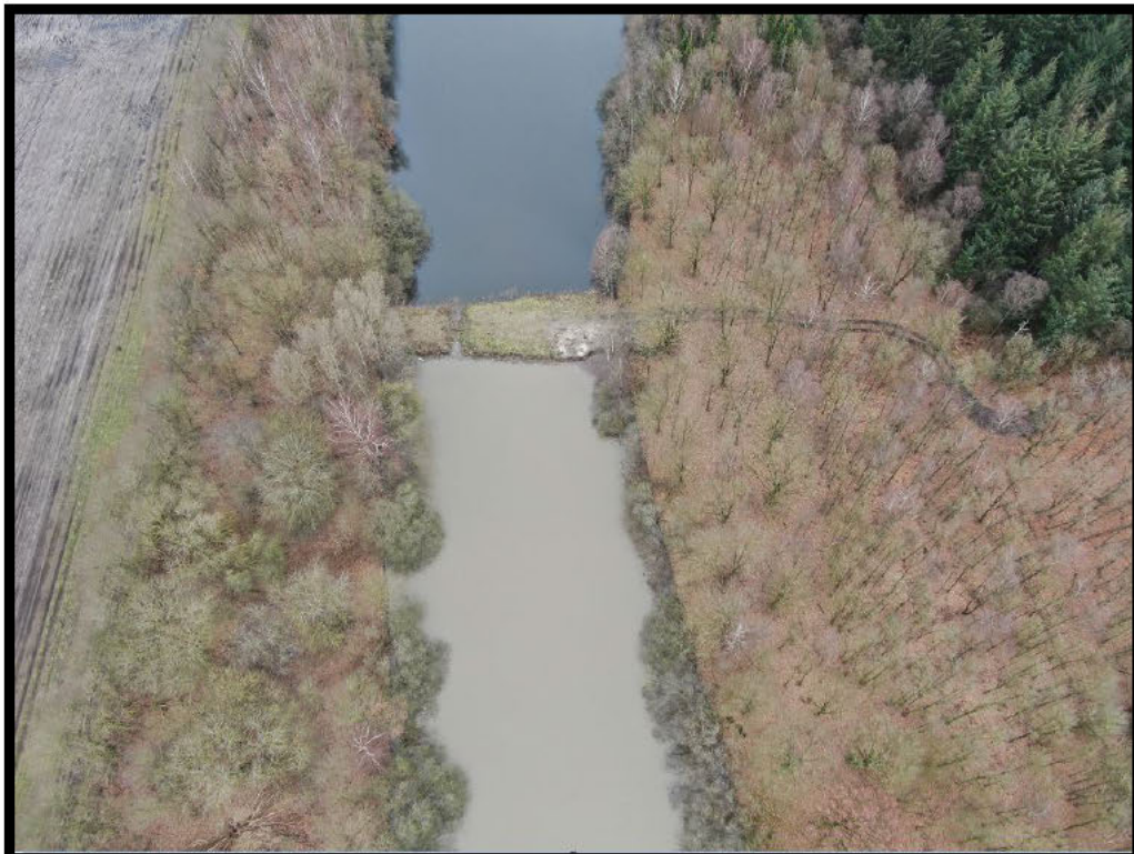
Foto 6 (dronefoto): Toepassingslocatie Schippersplas geen doorzicht in het oppervlaktewater van de toepassing. Het oppervlaktewater is grauw van kleur. Achterliggende deel van de Schippersplas is helder.
