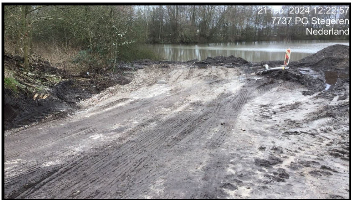
Foto 9: Op de reed toegepaste grond is een bouwstof zijnde gebroken puin toegepast t.b.v. tijdelijke verharding.
