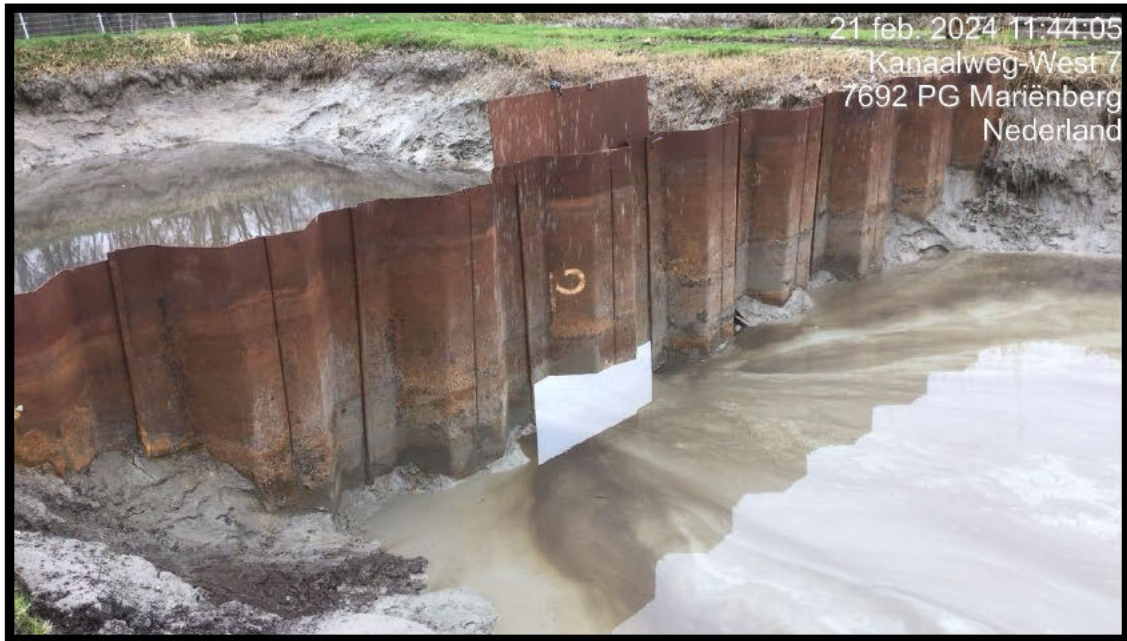
Foto 3: Open schot gezien vanuit bassin 2A
