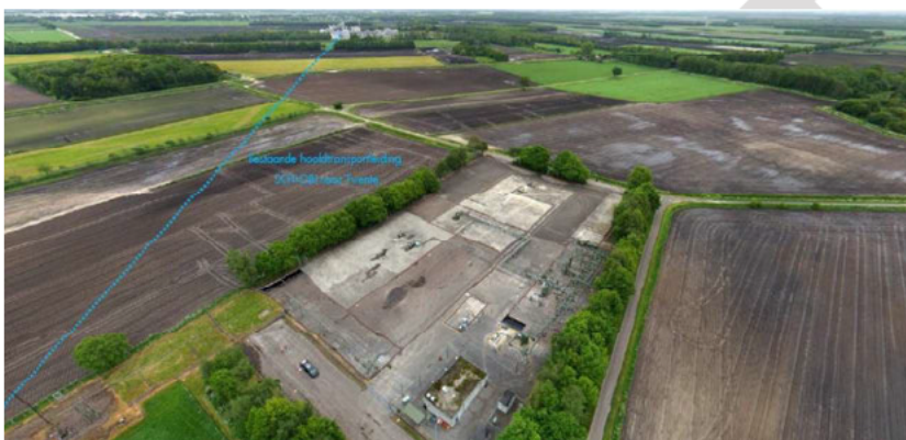
Locatie SCH-447 (Gasproductie- en waterinjectielocatie Schoonebeek gasveld)
