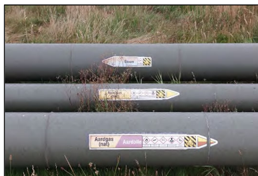
Figuur 4.10 Aanwezige bovengrondse leidingen.
