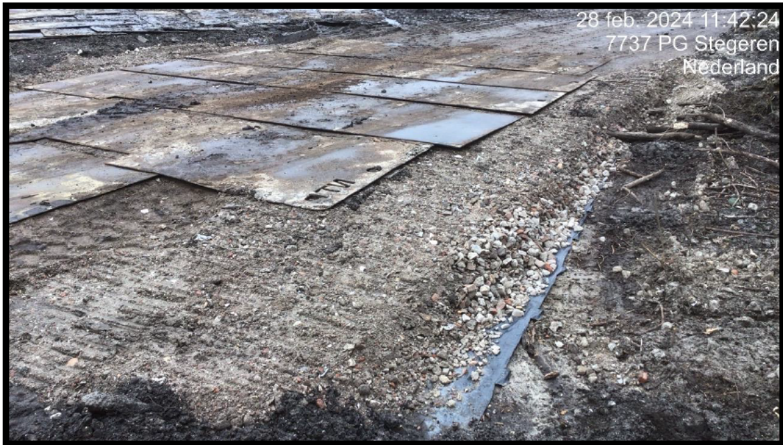
Foto 16: Op de reeds toegepaste grond is de bouwstof zijnde gebroken puin inmiddels voorzien van een beschermende onderlaag. Puin en rijplaten zijn t.b.v. tijdelijke verharding en worden niet toegepast in de verondieping.
