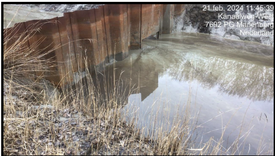
Foto 4: Open schot gezien vanuit bassin 2B
