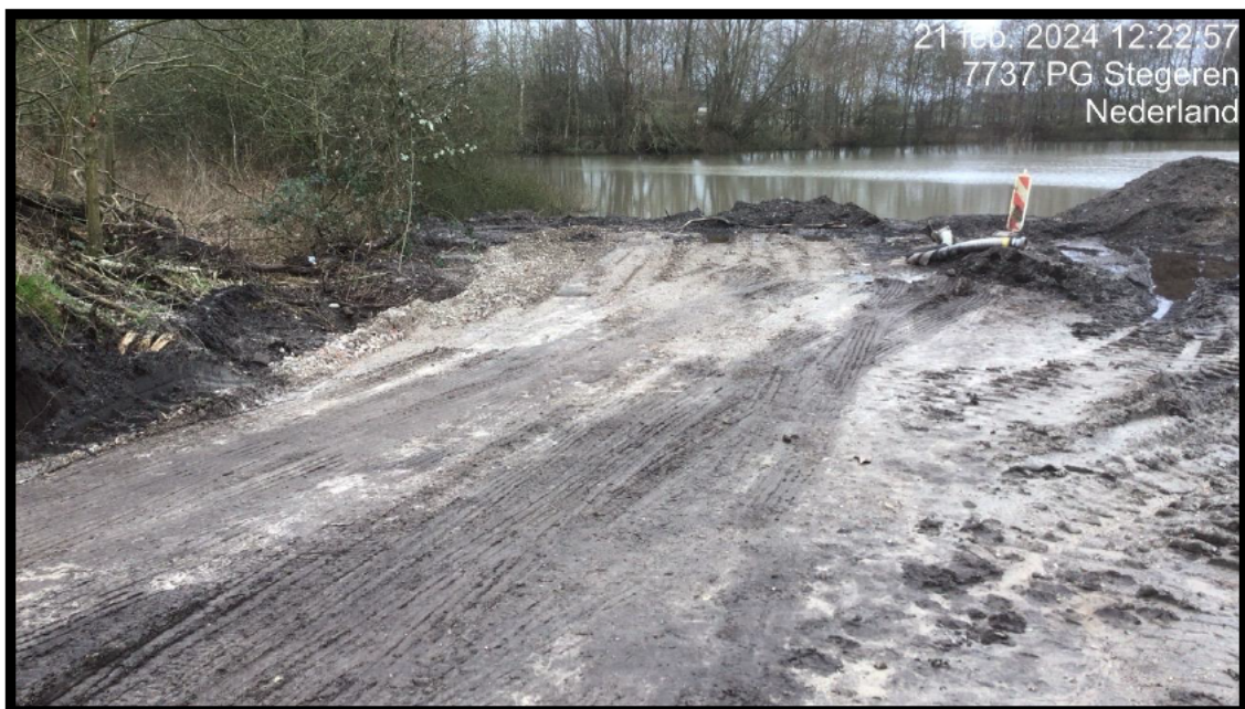
Foto 9: Op de reed toegepaste grond is een bouwstof zijnde gebroken puin toegepast t.b.v. tijdelijke verharding.
