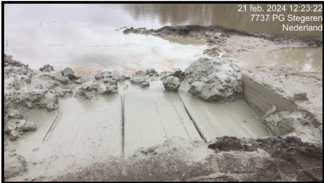
Foto 10: Toepassingslocatie Schippersplas geen doorzicht in het oppervlaktewater en voor op de foto is zichtbaar dat mogelijk vloeibare bentoniet is toegepast.
