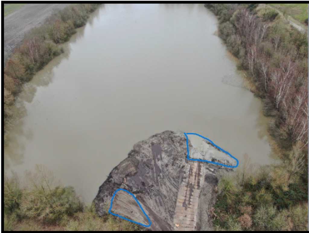
Foto 5 (dronefoto): Toepassingslocatie Schippersplas geen doorzicht in het oppervlaktewater. Het oppervlaktewater is grijs van kleur. Links bouw omcirkeld is een bouwstof zijnde gebroken puin toegepast. Rechts blauw omcirkeld mogelijk vloeibare bentoniet toegepast.
