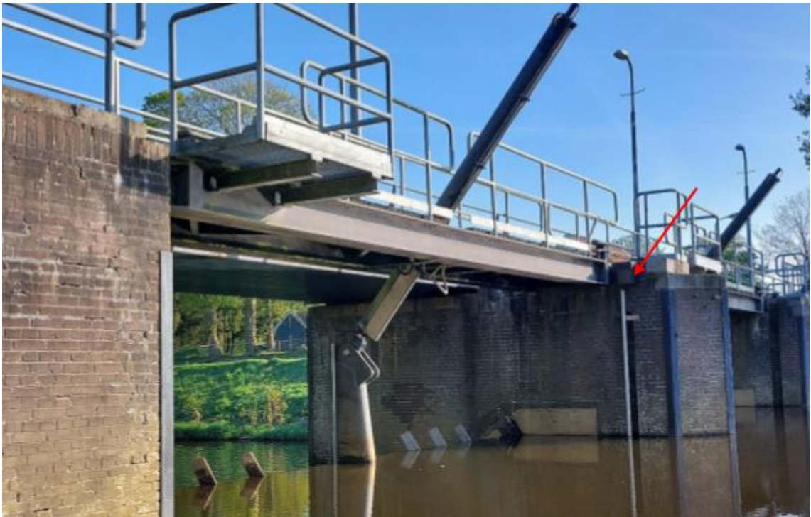
Nestplaats grote gele kwikstaart aan de binnenzijde van de westelijke pijler (bovenstroomse zijde). Foto Ecogroen
