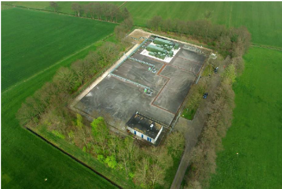
Figuur 2. Voorbeeld van een waterinjectielocatie met waterinjectieskids
