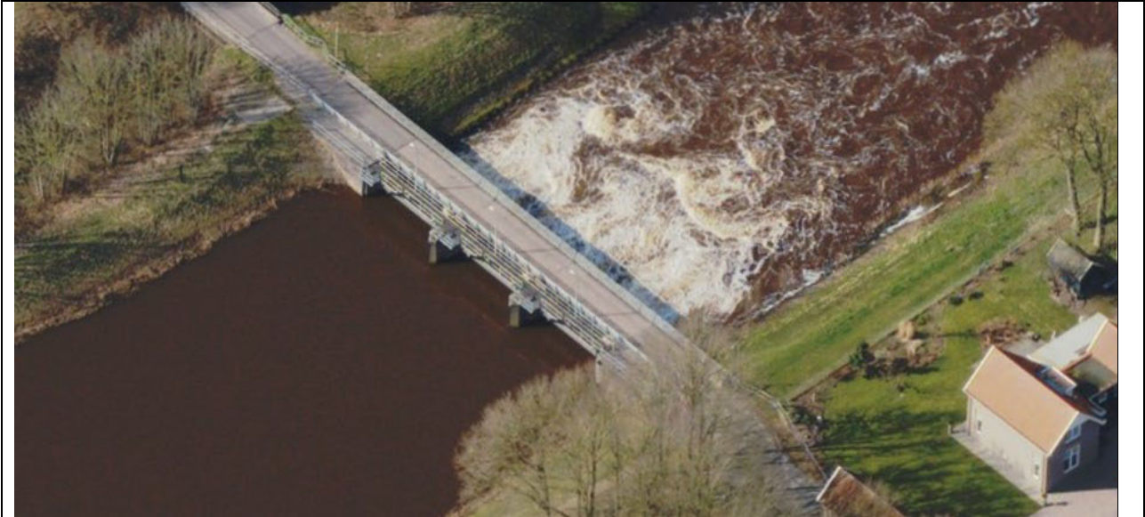
Figuur 1 Locatie Stuw Junne, Junnerweg te Stegeren, Bron: Cyclomedia
