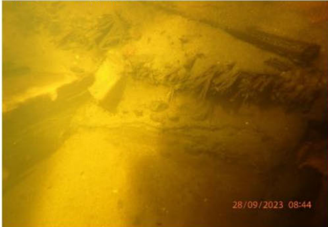
Figuur 4.5 Strolaag vastgezet met stokken
