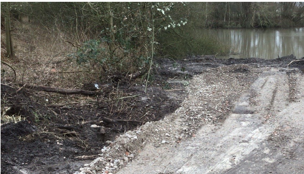
Toegepaste gebroken puin.
