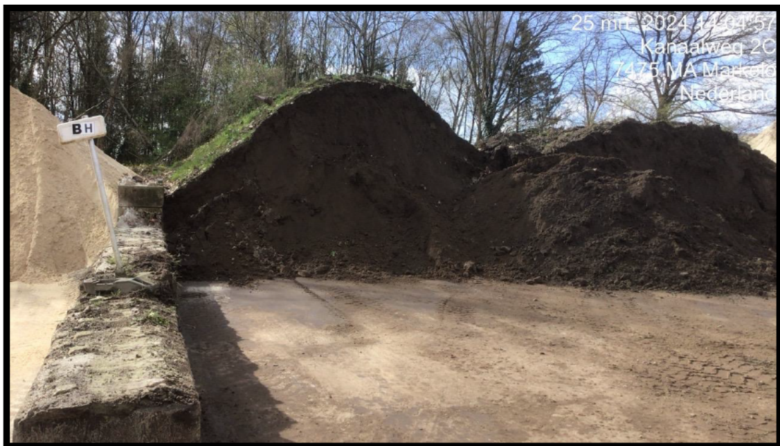
Foto 4: Partij grond BH deel 1 in vak BH depot deel 1
