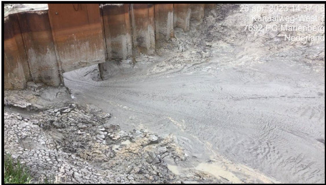
Foto 3: Geopende schuif tussen bassin 1A en 1B gezien vanuit bassin 1B
