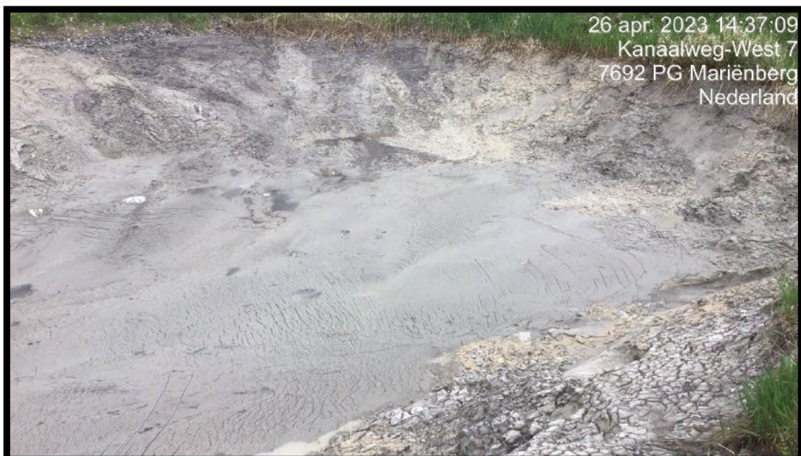
Foto 4: Bassin 1B, enkel nog de vaste niet verpompbare fractie van bentonietslurry aanwezig.
